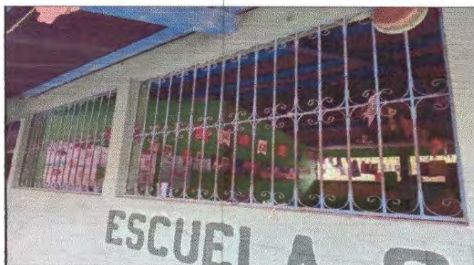
Foto 4: Mantenimiento a balcones
