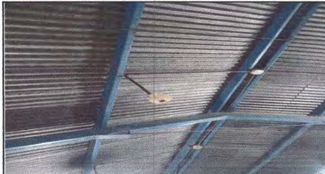
Foto 2: Mantenimiento a estructura de soporte de metal
