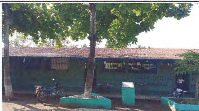
Foto 1: Sustitución de lámina
