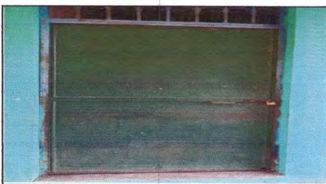
Foto 10: Pintura a puertas servicios sanitarios
