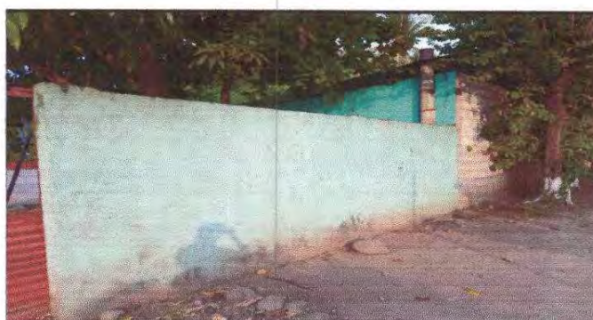
Foto 6: Pintura en muros exteriores
