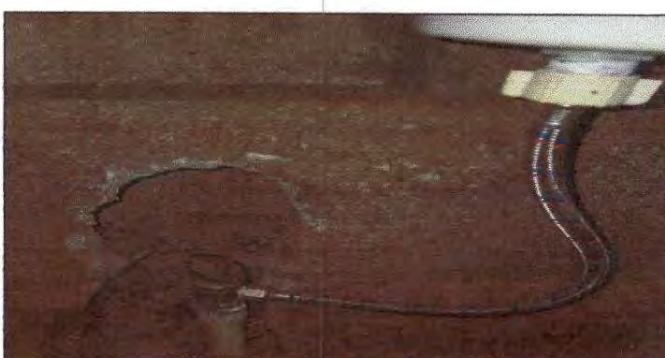
Foto 12: Sustitución de llaves de paso
