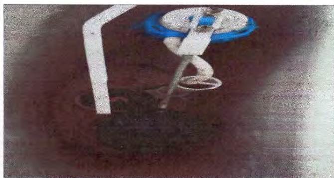
Foto 11: Sustitución de accesorios inodoro
