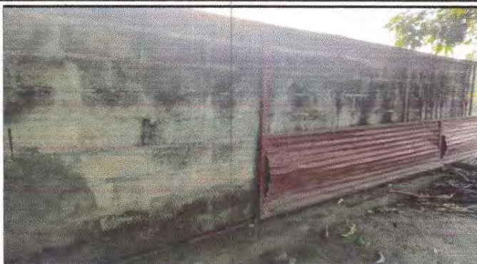
Foto 14: Repello de muro
