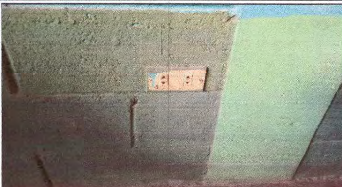
Foto 8: Sustitución de tomacorrientes dobles
