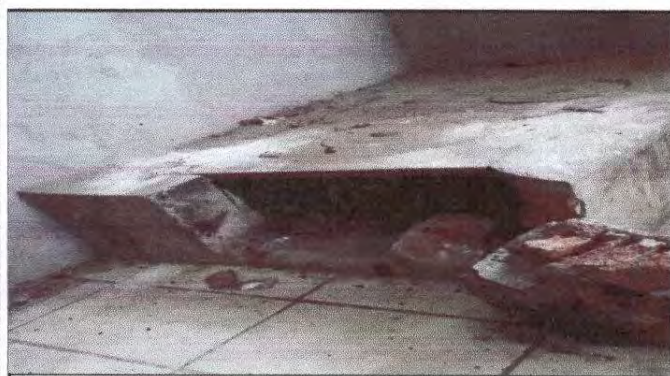
Foto 9: Sustitución de plancha de metal 3 hornillas
