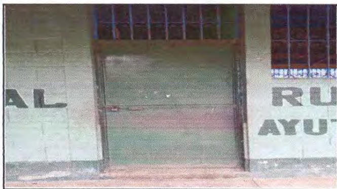
Foto 3: Mantenimiento a puertas aula
